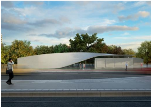
Bild: Ergebnishaushaus des C 3 -Vorhabens „TWIST“ Carbonbetonschale in Kombination mit einem Wandbau aus Carbonbetonelementen
